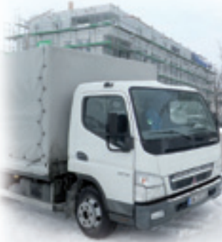
Da paßt was rein: Der Canter vor der Baustelle
