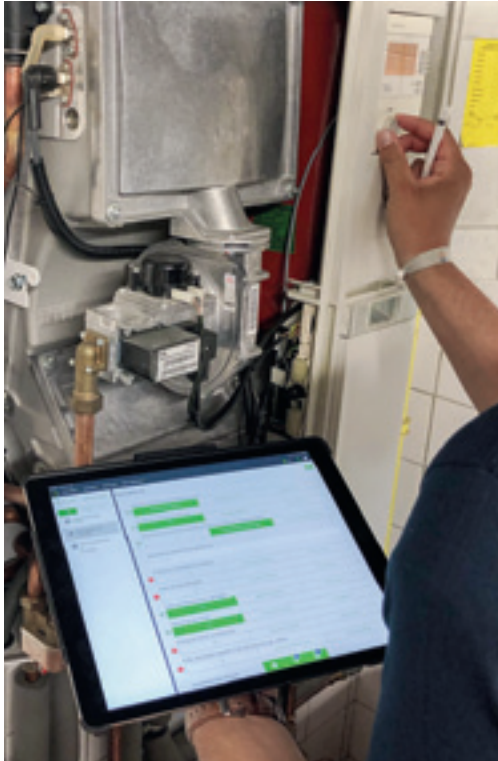
Die Monteure haben vor Ort Zugriff auf alle notwendigen Informationen und können alles direkt dokumentieren.
