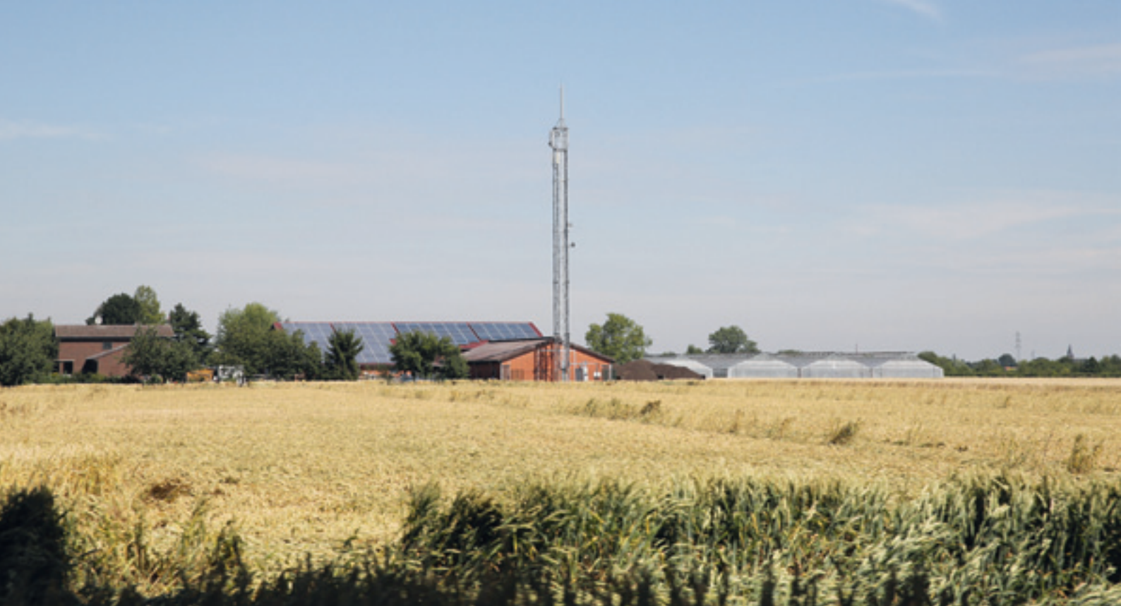
Mobilfunkmast zur Versorgung im ländlichen Raum (Bild: Bundesnetzagentur)
