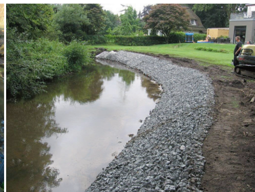
Alsterböschungssicherung mit Steinwalzen
