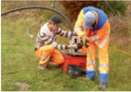
Verlegung des Glasfaserkabels für Bodelsberg: Mitarbeiter des AÜWs beim Einpfügen der Leitungen.
