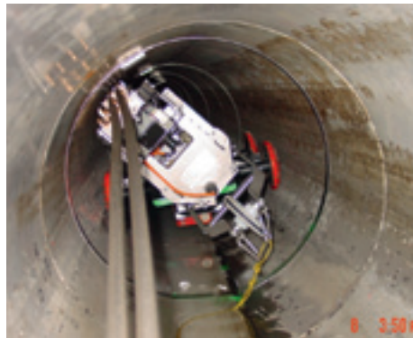
Roboter im Kanal (Fast Opticom)
