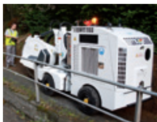
Schmale Maschinen ermöglichen das Verlegeverfahren auch auf engem Raum (Bild: BVs-net GmbH)
