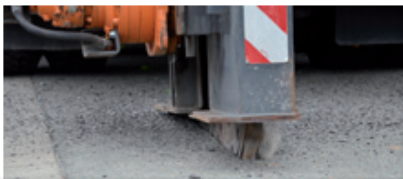
Spezielle Maschine fräsen die Straßenoberflächen auf (Bild: Kellner Telecom)
