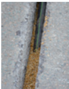
Das Glasfaserkabel wird in der Sandschicht verlegt (Bild: Kellner Telecom)
